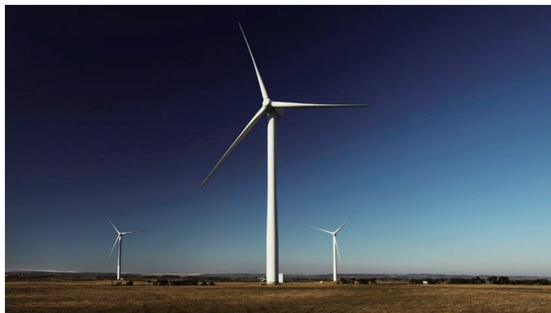
安哥拉纳米贝省 Tombwa 地区风力发电厂及配套输电系统建设项目，项目建成后将改善安哥拉南部地区居民的用电条件
