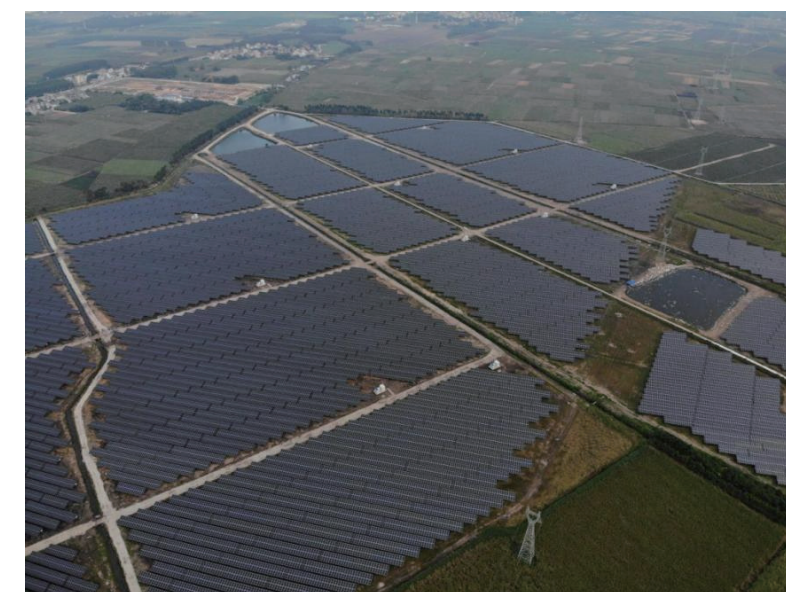
遂溪县杨柑镇农业光伏项目
