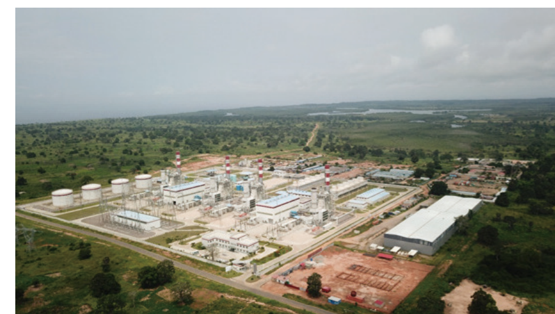
安哥拉索约联合循环电厂项目
