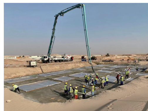
建设中的艾尔达芙拉电站项目
